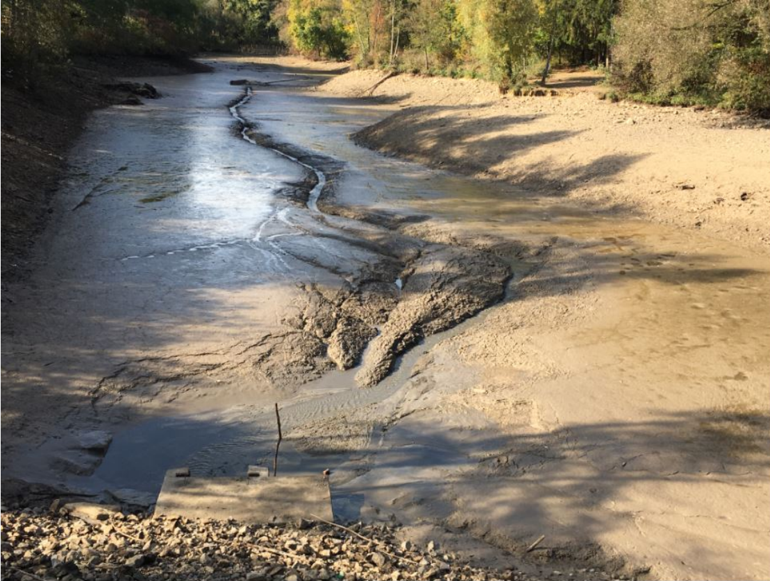
Gewässersohle vor der Entschlammung
