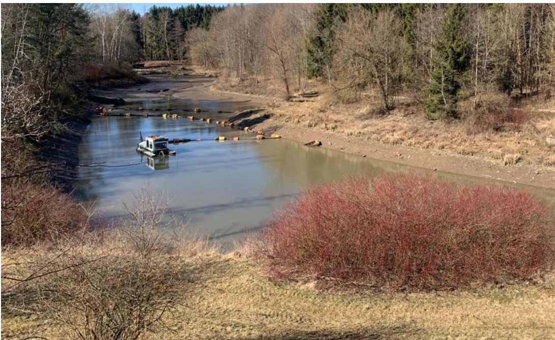
Schwimmbagger im Einsatz
